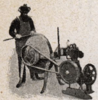
Pumpmotorn dragande en slipsten.
