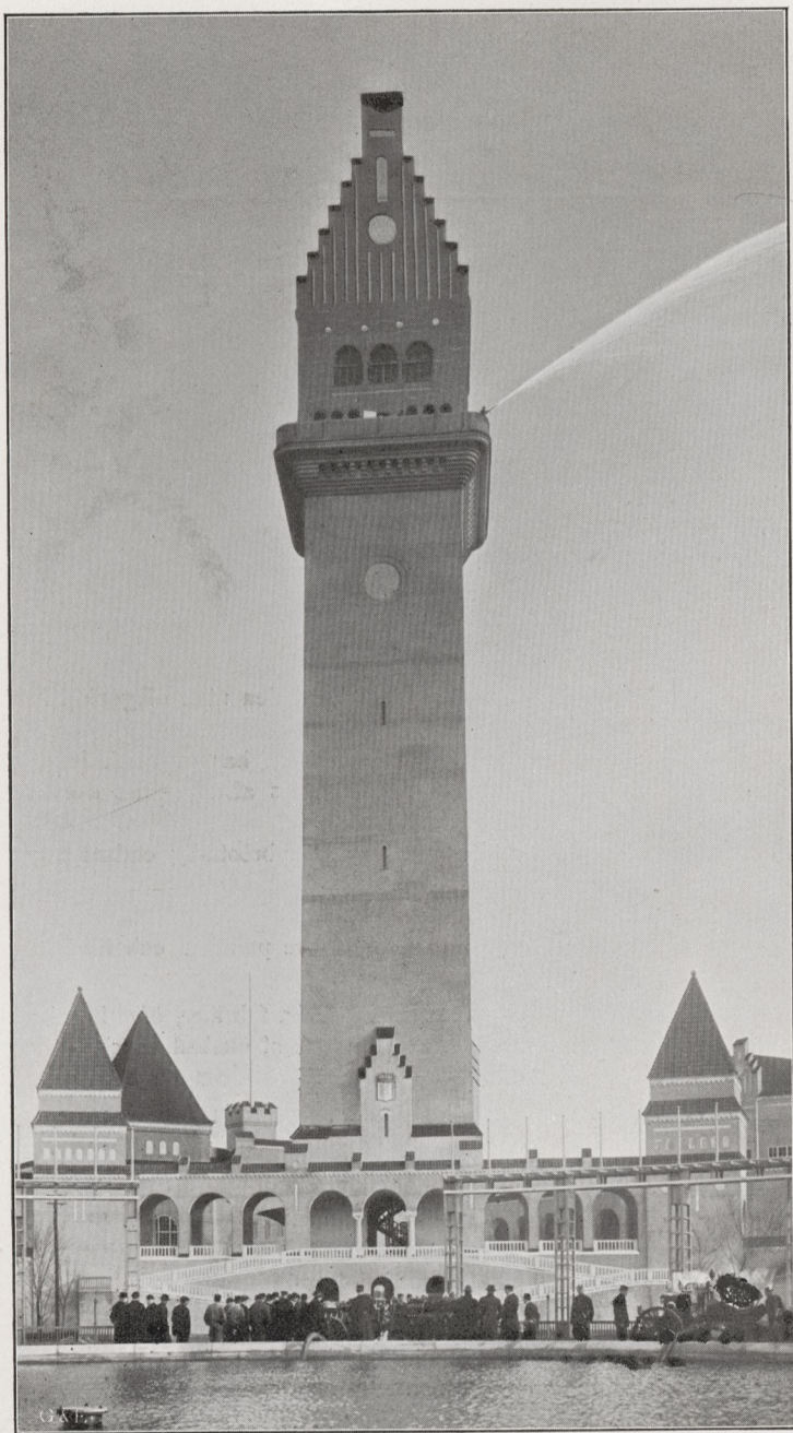
På Baltiska Utställningen i Malmö verkställdes d. 27/2 d. å. prof med Henrikssons Motorspruta N:o 14 B, hvarvid drogs en 150 mtr lång slangledning upp till utställningstornets 66 m. höga balustrad och inom 1 min. efter startsignalen slungades en kraftig stråle ut i rymden.
