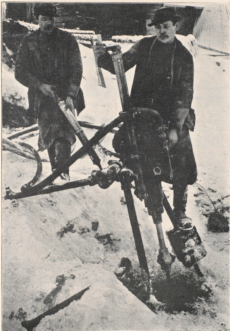
Morgårdshammars bormaskin, uppställd på trefot för borrar i stenbrott, pall eller schakt.
