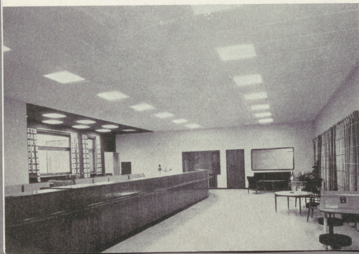
Fig. 3. Madesjö-Nybro Sparbank med i taket infällda armaturer för två 40 W cirkellysrör. Avskärmning av opalplast.
