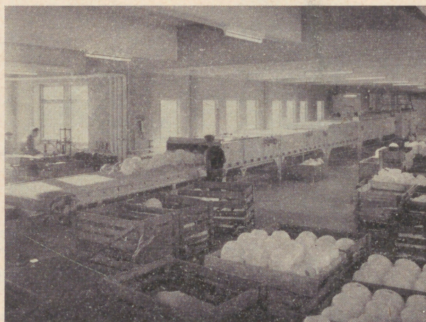
Fig. 8. Interiör av nya hyttan. Upptill de reglerbara spjällen i ventilationshuv.
