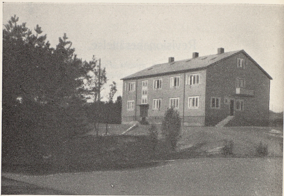
Personalbyggnaden sedd från öster
