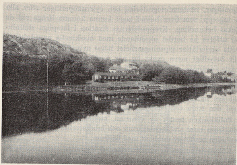
Fig. 3. Annexbyggnaden och sommarpaviljonger m. m. sedda från söder.
