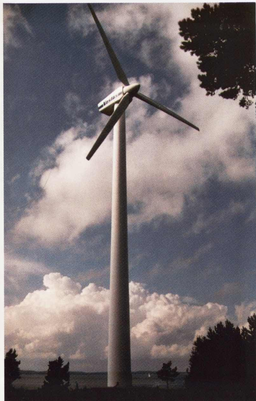
Skärgårdskraftverket sett inifrån öns skogsbryn.
