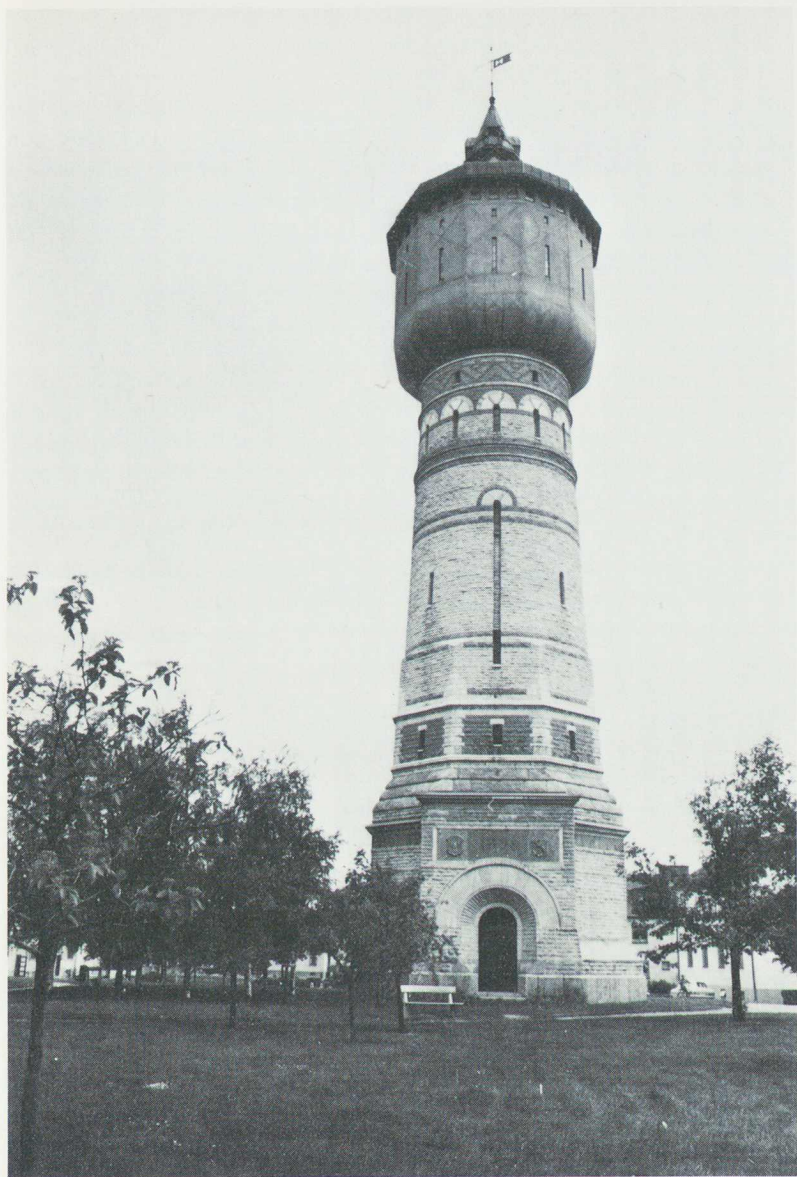
Vattentornet i Skara, uppfört 1896 i kalksten och en övre del i järn och betong som omsluter reservoaren. Foto Gunnar Sillén 1971, Riksantikvarieämbetet.
