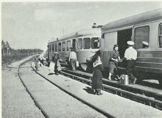
Nyanskaffning av lättare rullande järnvägsmateriel av den typ som nu används kommer sannolikt inte att ske.
