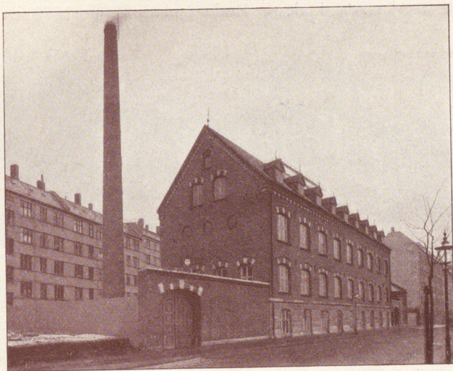
Cloettas chokladfabrik i Köpenhamn.
