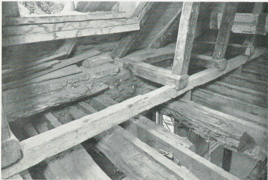
Fig. 21. Detalj av föregående. Iakttag: 1. rester av brandbotten. 2. takstolar, behandlade delvis med kalkning, delvis med eldfärg, maskstungna. 3. ursprungliga, mycket skadade bjälkar, vid tidigare reparation förstärkta med impregnerade träbjälkar.
