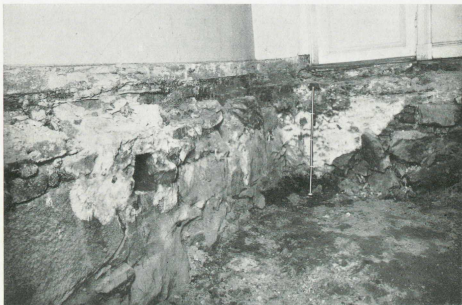
Fig. 30. Merulius lacrymans under golv i byggnad på Kungsholmen, Stockholm. 1 m 2 stora ytor till vänster och till höger fäckta av svampen.
