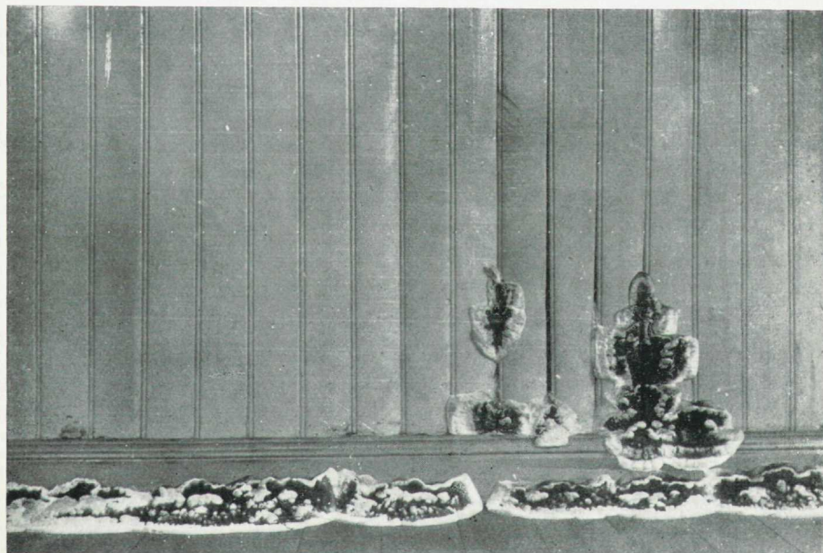
Fig. 27. Fruktkroppar av Merulius lacrymans på en vägghpanel i en skola.
