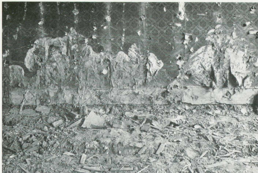
Fig. 26. Merulius lacrymans bakom en borttagen vägghpanel. De gamla tapeterna sitta kvar.
